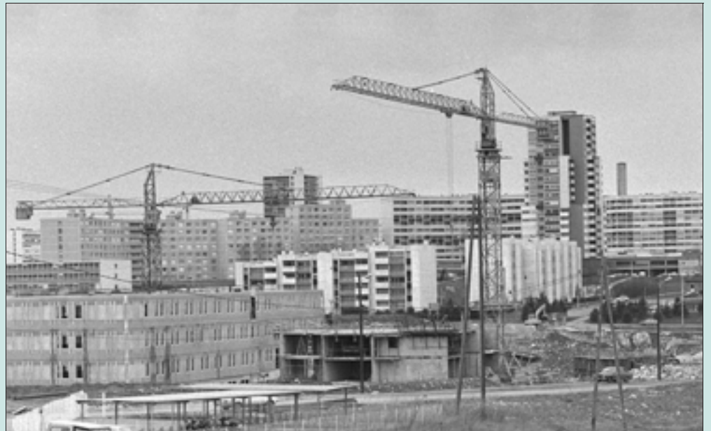
À voir l'état d'avancée du chantier du futur lycée Victor-Hugo à Planoise ici en mars 1980, il n'est pas difficile de s'imaginer qu'à la rentrée, les élèves avaient dû côtoyer les machines, le bruit et la poussière. Photo archives ER/Bernard Faille/memoirevive/villedebesançon
