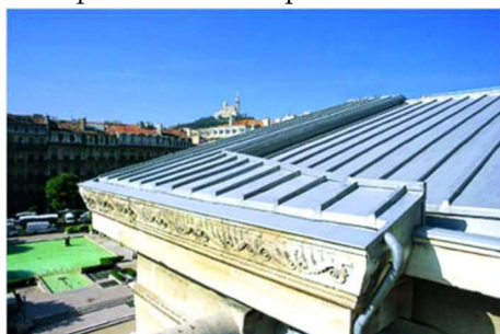
FIGURE 10 – Toiture en zinc
