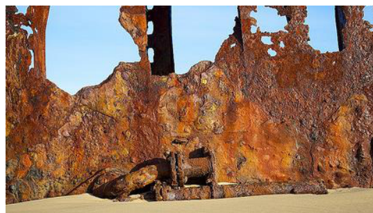
FIGURE 7 – Épave de bateau : la couche de rouille n'a pas protégé le métal en profondeur
