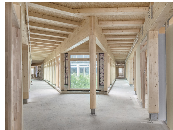
Photo de chantier du groupe scolaire du quartier des Horizons à Evry-Courcouronnes
